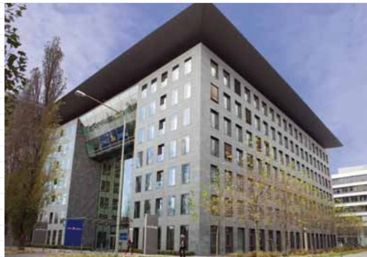
Der Direktbank ist es gelungen, mit einer speziellen Software die Bewertungsgenauigkeit in der Baufinanzierung zu verbessern und die Prozesse zu optimieren.
